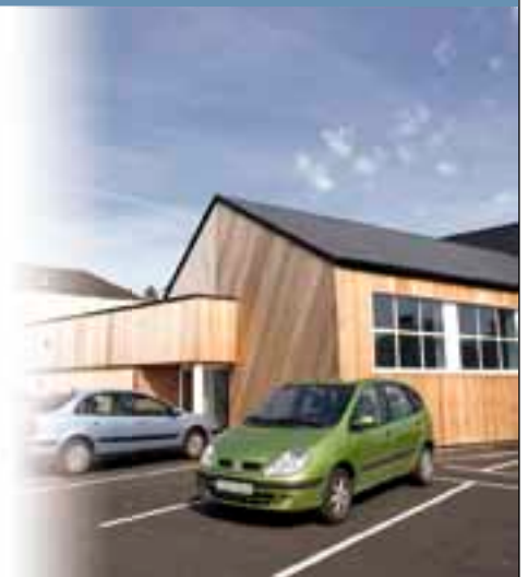
Exemple de réalisation avec l'extension du gymnase Klein à Courville-sur-Eure.
